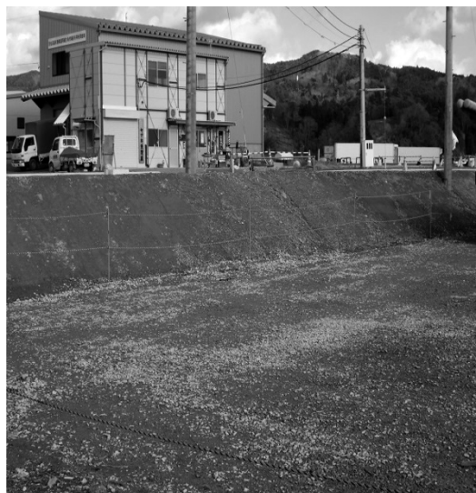
図4 かさ上げの一部
