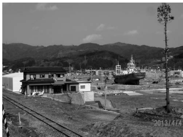
図2 共徳丸解体直前
