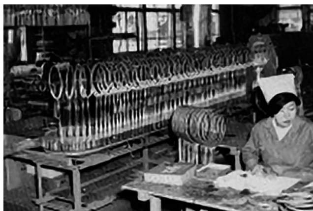
当時の工場の様子
